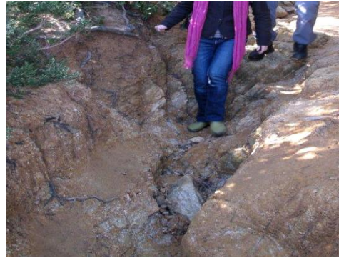
Figure 14 : Erosion d'un chemin aux Petites Maures
