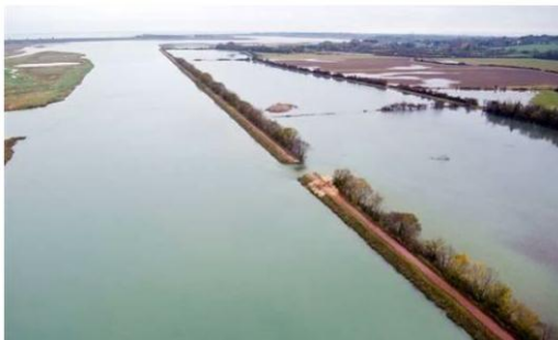
Figure 8 : marais de Cagny suite à la rupture de la digue en 2011 (photo : P. Henry)
