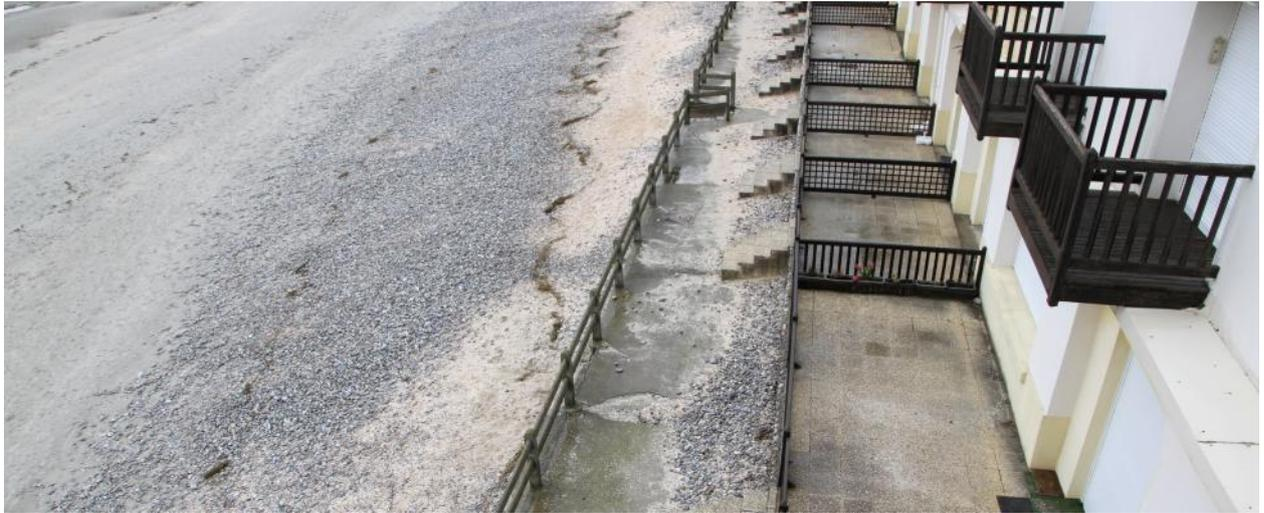
**Figure 9 : Dépôts de galets sur le bâti du littoral Sud (photo : T. Binet 2015)**
